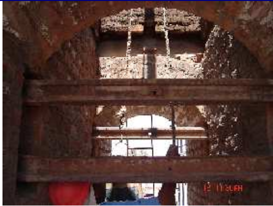
Fig. 7 Instalación de barras fijas
