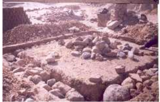
Fig. 2 Excavación y preparación de cimientos para horno vertical
