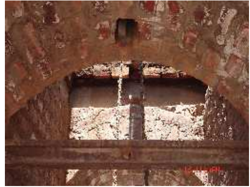
Fig. 8 Bóveda con el gancho para colgar tacle
