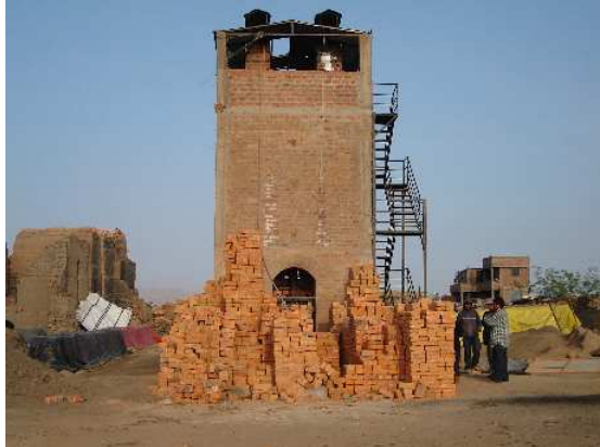
Fig. 11 Horno vertical en Arequipa con escalera metálica
