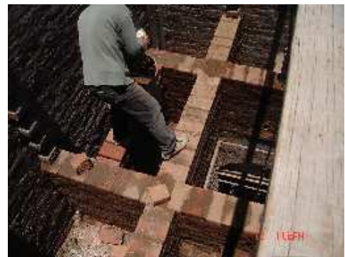
Fig. 6 Vista de paredes interiores
