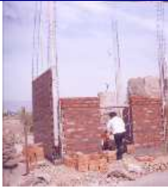
Fig. 3 Levantando columnas y paredes iniciales
