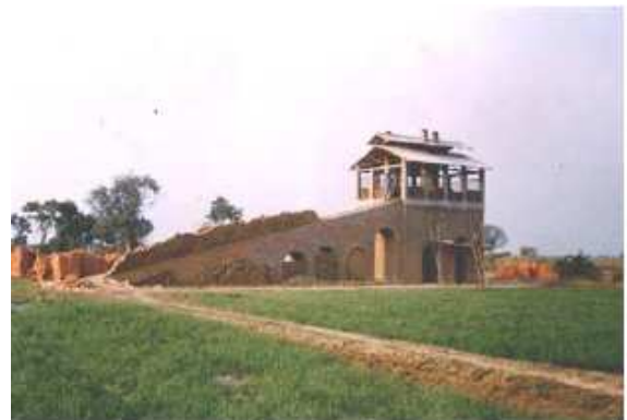
Fig. 12 Horno vertical en Pakistán con escalera de ladrillo
