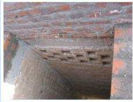
Fig. 5 Eje con agujeros de salida para chimenea
