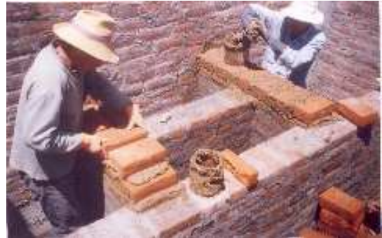
Fig. 4 Armado de muros de ladrillos
